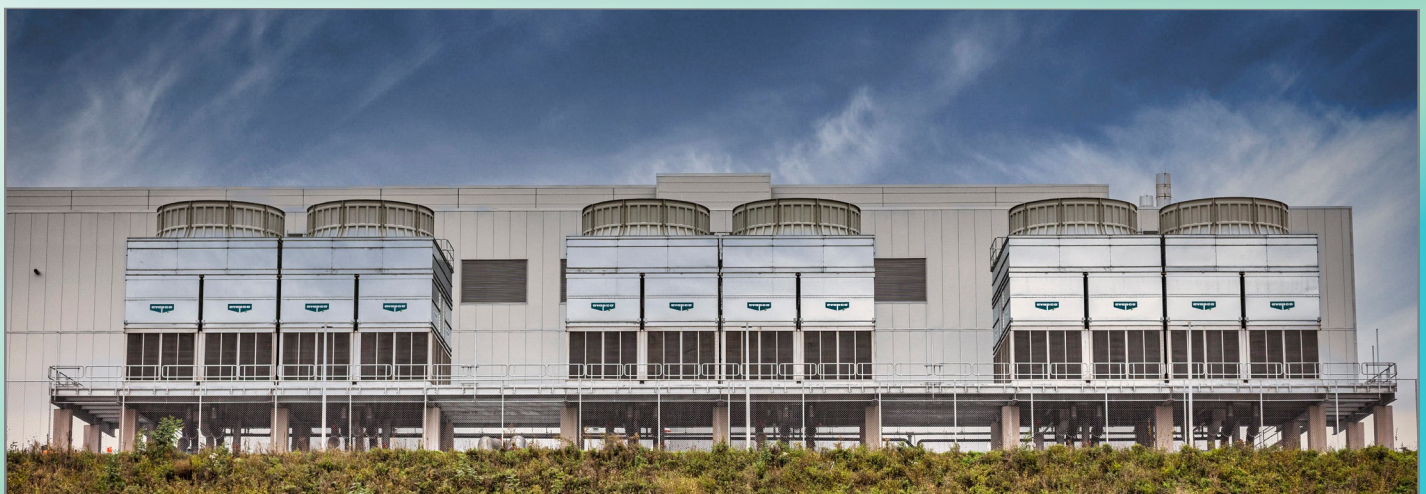
Lắp đặt AT Atlas
