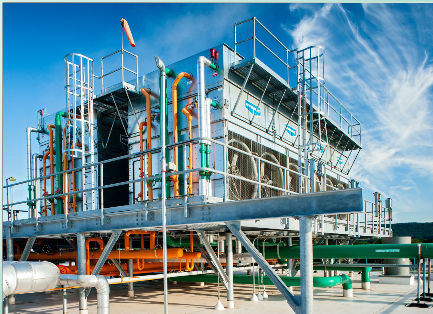
Bình ngưng bay hơi PMC-E với nền tảng dịch vụ bên ngoài tùy chọn
