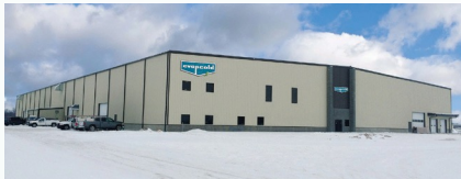
Sản xuất Evapcold, Greenup, Illinois
