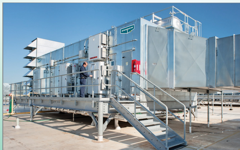
Hệ thống xử lý không khí hợp vệ sinh Critical Process Air (CPA)
