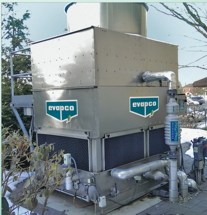
Tháp giải nhiệt AT với Hệ thống xử lý nước không dùng hóa chất Pulse ~Pure® tùy chọn
