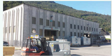
EVAPCO Europe, S.r.l., Sondrio, Italy
