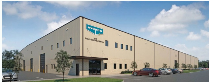
Tòa nhà chính EVAPCO, Taneytown, Maryland
