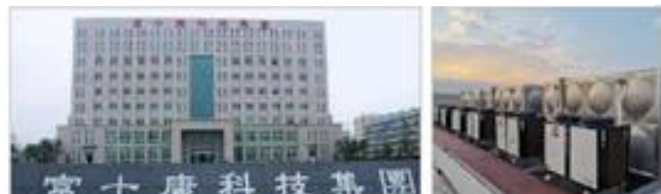
Dự án nước nóng Tập đoàn Công nghệ Foxconn
