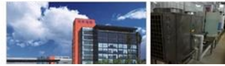
Dự án máy bơm nhiệt mạ điện mạch Shennan
